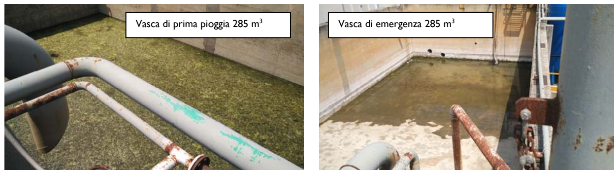
Figura 6-2. Vasca di prima pioggia e ulteriore vasca di emergenza
