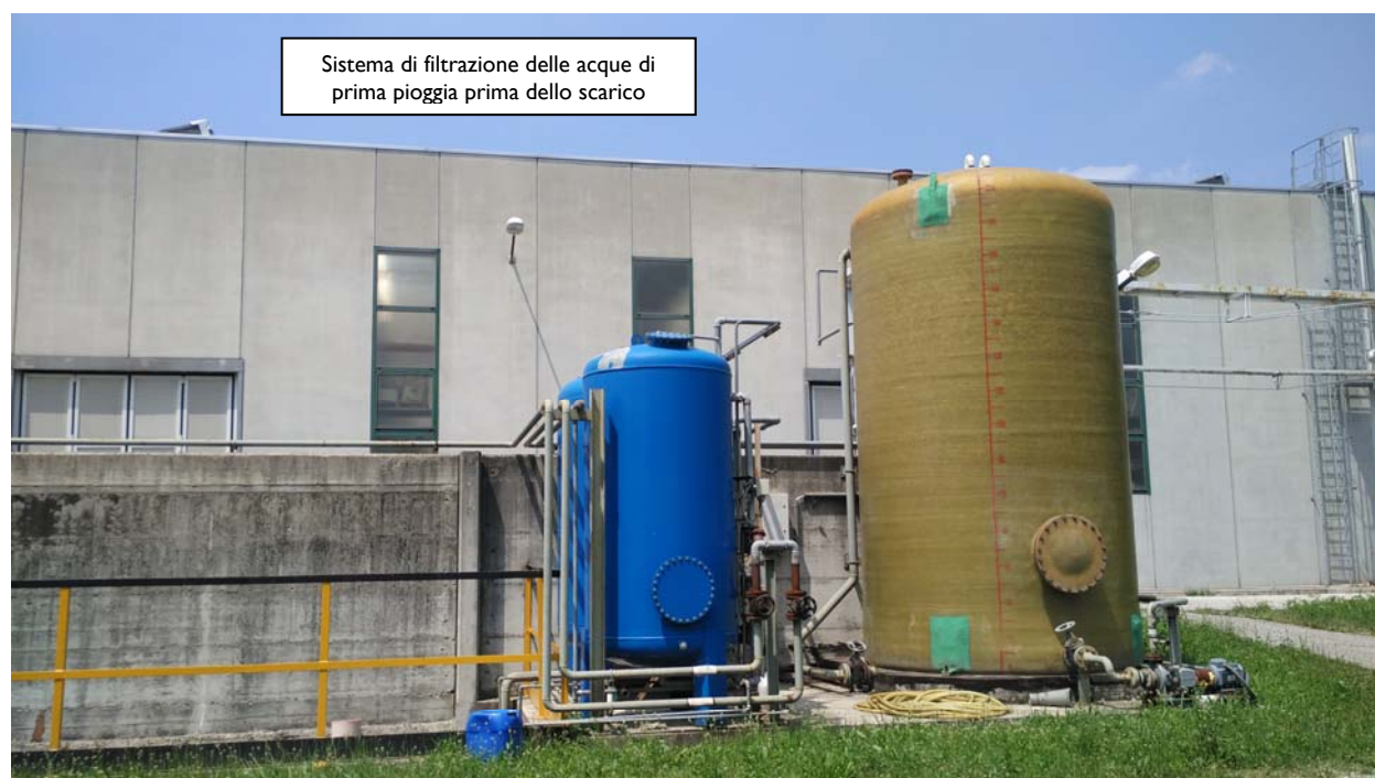
Figura 6-3. Vasca di prima pioggia – Sistema di filtrazione finale prima dello scarico
