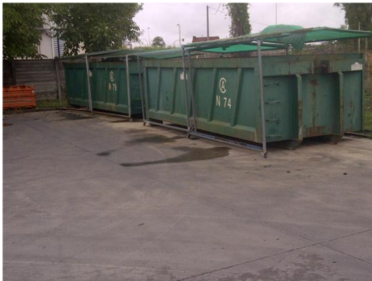
Foto 1 : stoccaggio fanghi filtropressati
