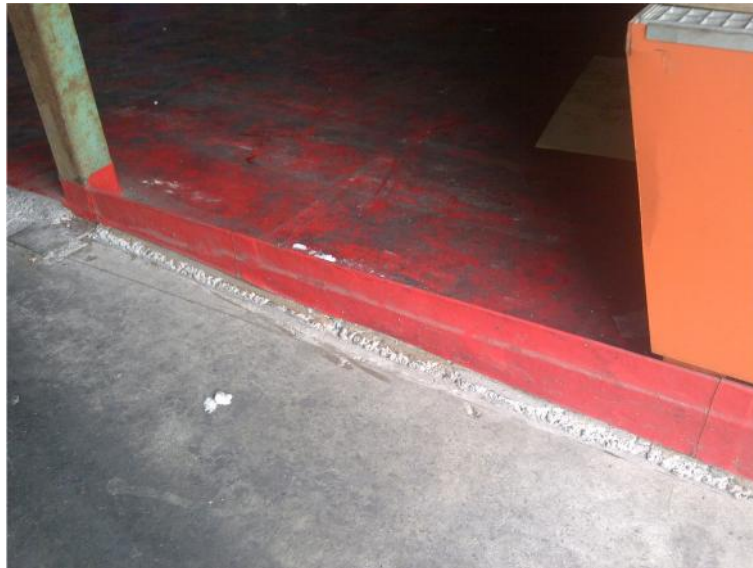
Foto 5 : pavimento impermeabile e soglia rialzata contro le perdite Locale di stoccaggio materie prime liquide
