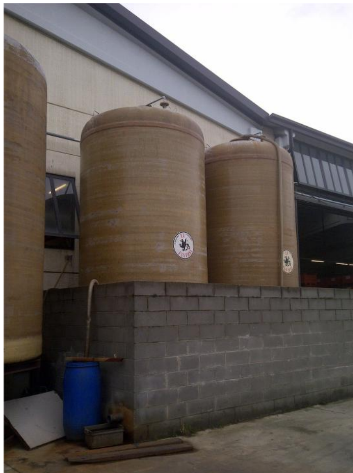
Foto 6 : stoccaggio prodotti liquidi su bacino di contenimento
