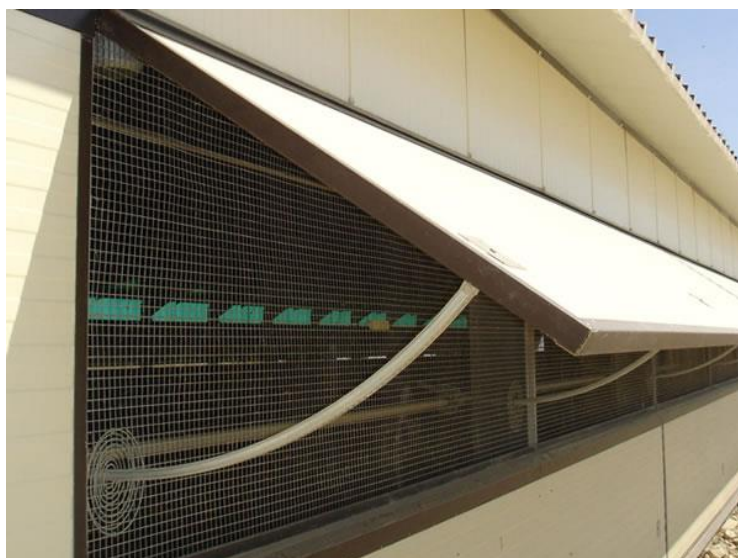
Foto 4 : visione della presa d'aria intermedia
