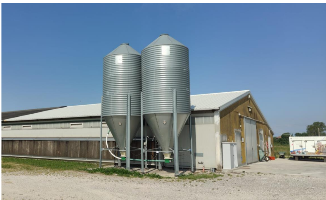
Foto 13 Visione dei silos
