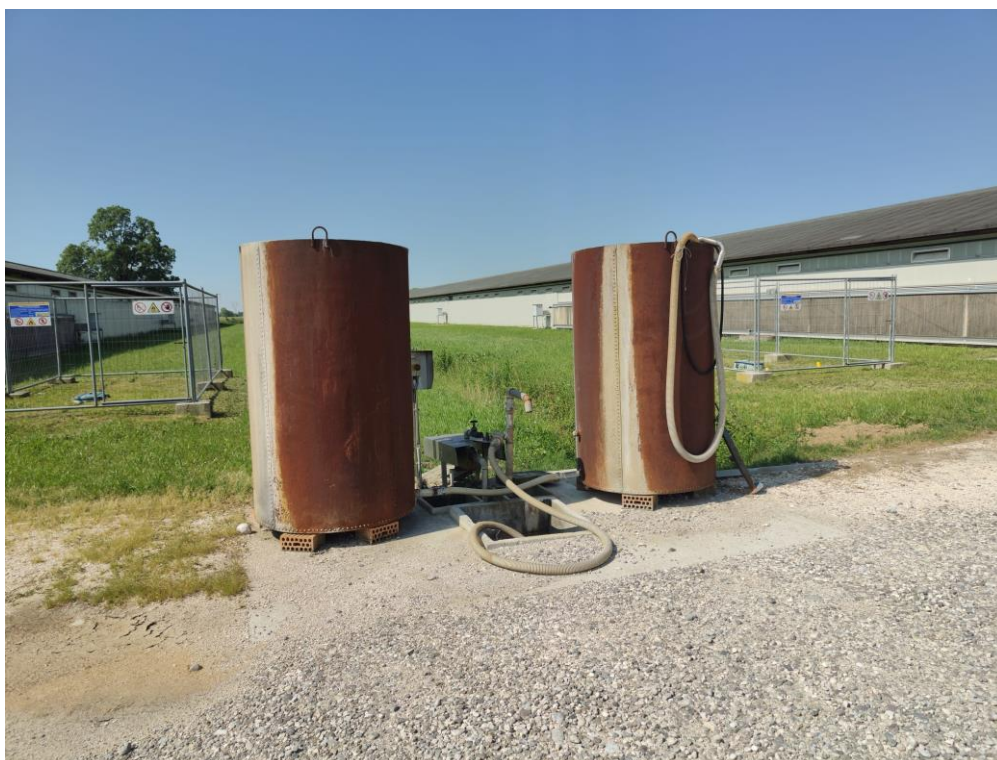
Foto 23: pozzo artesiano con serbatoi di accumulo
