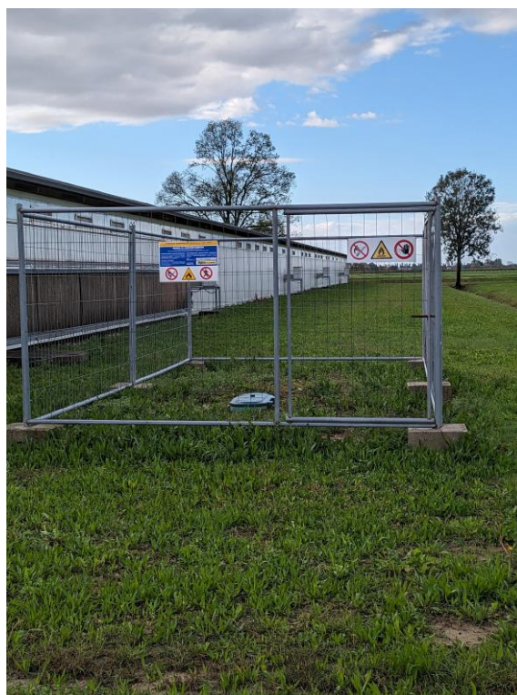
Foto 15. Visione del serbatoio GPL interrato
