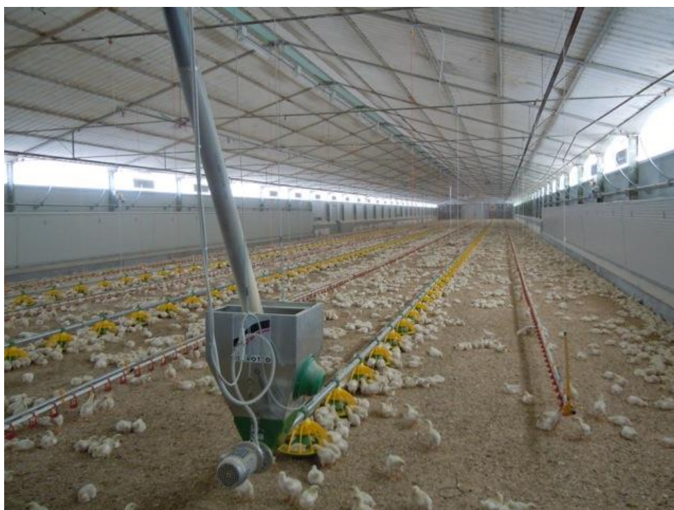
Foto 9: visione della tramoggia e linea di distribuzione del mangime
