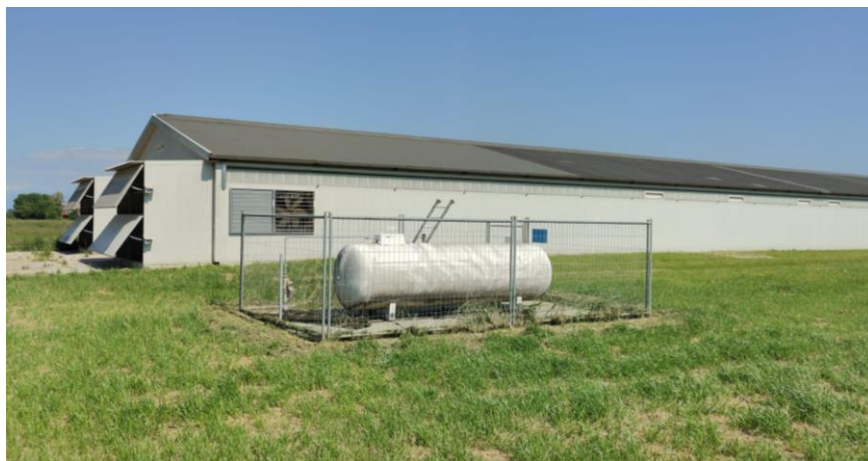
Foto 14. Visione del serbatoio GPL esterno
