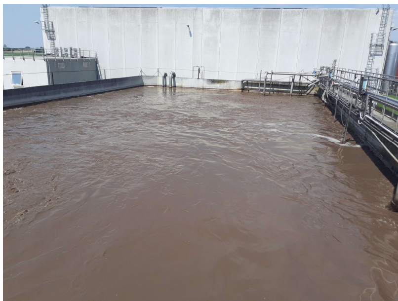
Figura 5: Particolare fotografico vasca ossidazione.
