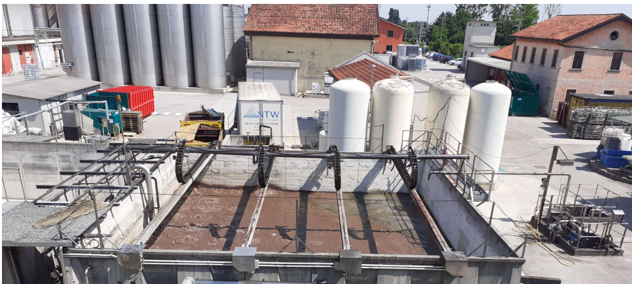
Figura 6: Particolare fotografico vasca ispessimento fanghi e membrane.
