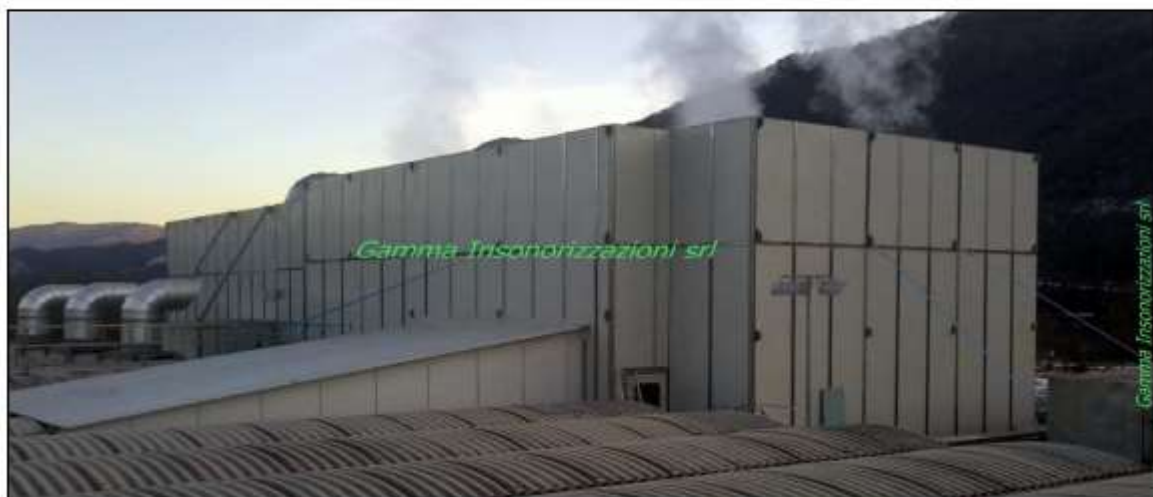
Foto 1- Esempio barriera modulare SX-1 installata in copertura a bonifica acustica impianti di cogenerazione. Pannello
