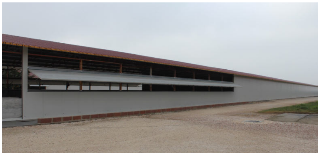
Figura 3: Particolare delle finestre a vasistas, prima del posizionamento del cooling, in un'azienda simile
