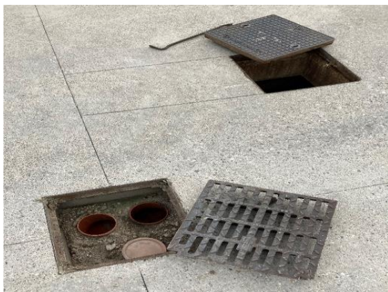
Foto17-18. Vista dei pozzetti e dei tubi di scarico
