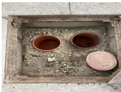
Foto17-18. Vista dei pozzetti e dei tubi di scarico
