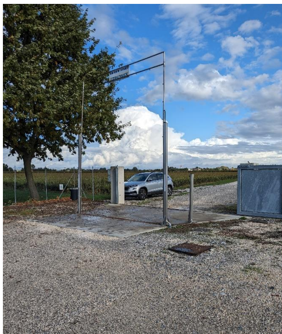
Foto 20. Arco di disinfezione in corrispondenza dell'accesso carraio
