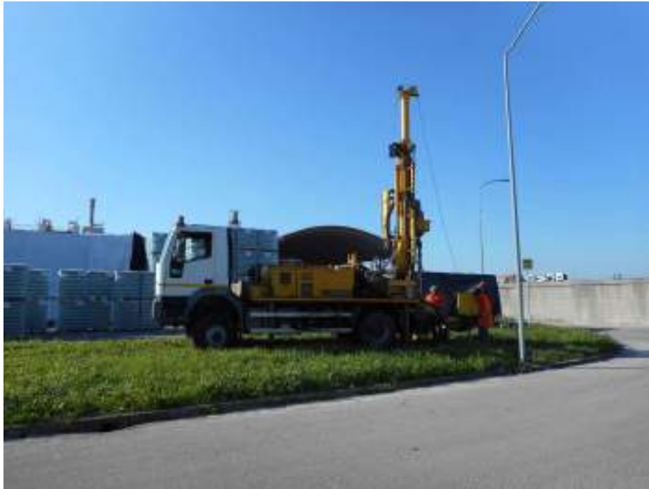
Sondaggio P17: posizionamento delle attrezzature.
