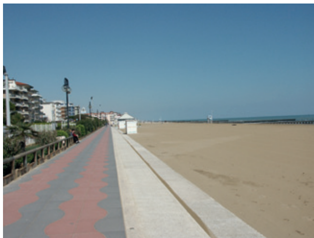
Fig. 19.6 - Difesa rigida del retrospiaggia sul litorale di Jesolo.
