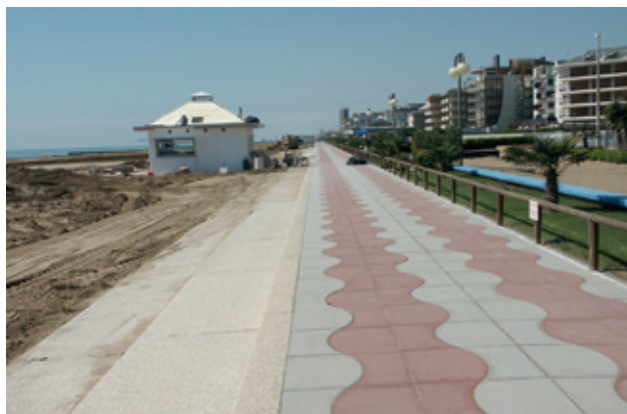
Fig. 19.16 - Difesa rigida costruita in tempi recenti sul litorale di Jesolo.
