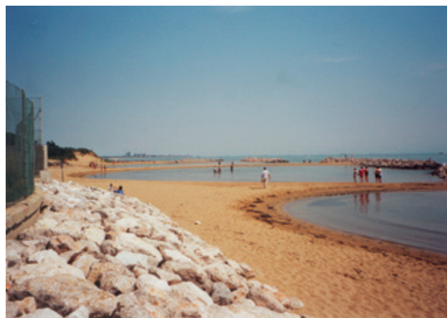
Fig. 19.4 - Difesa a mare emersa presso il faro di Punta Tagliamento sul litorale di Bibione.
