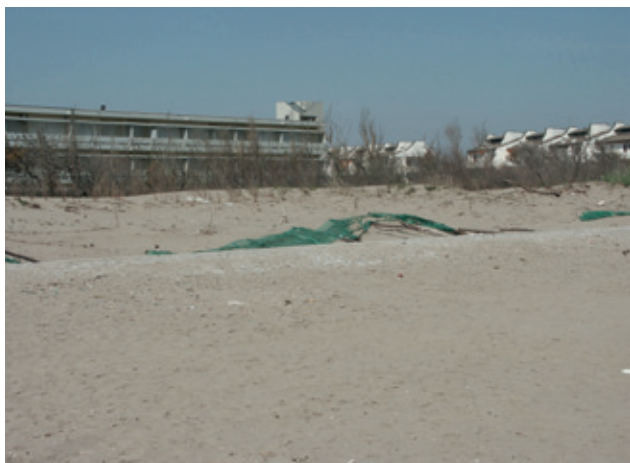
Fig. 19.10 - Tratto del litorale di Isola Verde protetto da una difesa rigida parzialmente interrata, alle spalle è visibile un discutibile intervento di stabilizzazione della duna con piantumazioni e reti frangivento.
